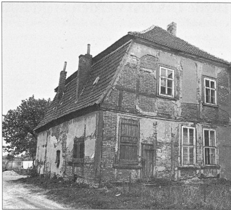
Um endlich mit der Sanierung beginnen zu können, ist noch „grünes Licht“ von der Bank notwendig. Fotos: W. Kühn
